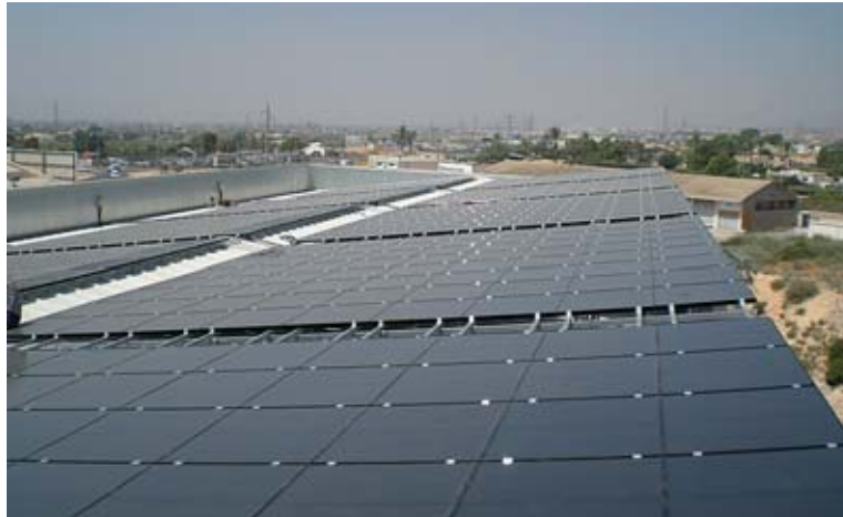
LA PLANTA SOLAR GENERA UNA POTENCIA DE 100 kW NOMINALES
