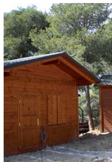
BUNGALOWS CON INSTALACIÓN GEOTÉRMICA DE ENERGESIS
