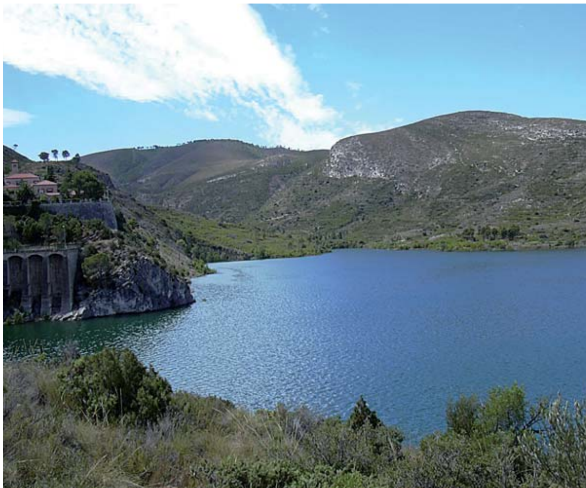
LOS EMBALSES DEL SISTEMA TER-LLOBREGAT, QUE ABASTECEN A BARCELONA, ESTÁN AL 54 POR CIENTO.
